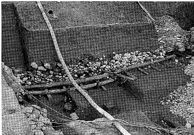
入堀で出土した珍しい梯子土台木二本の丸太の下に枕木を添えて杭で留めている。背後の河原石は石垣の裏込め石
