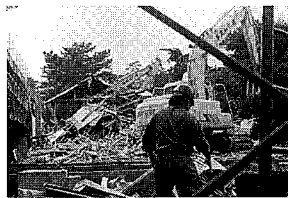
元城内小学校解体
