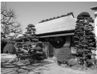
葺屋根葺替え後の飯山家母屋
