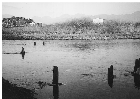
酒匂側よりから見た甦った橋杭 (左奥の樹林が旧網一色村八幡社)
