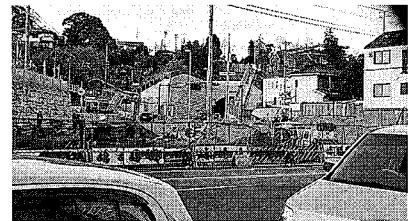
↑城山トンネル開通間近 山角町にて
