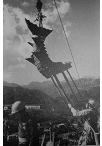
写真10 小田原城にシヤチを据え付け 昭和35年
