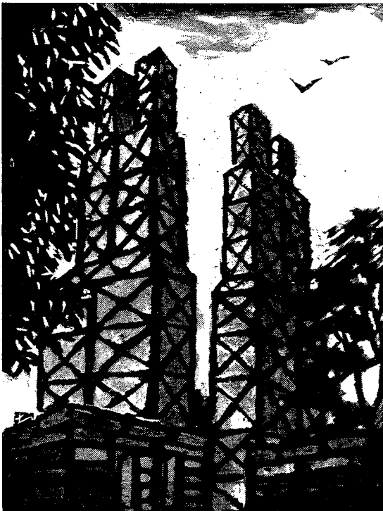
江川太郎左衛門英龍が幕府に建議して、安政元年6月起工したが11月安政大地震、翌年英龍の病死などの困難を乗り越え、同5年完成。品川台場や各藩の大砲を製作した。国指定史跡(本年初詣で見学)
