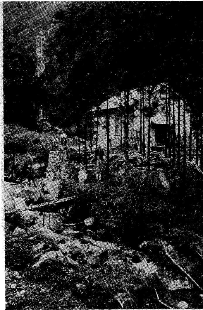
工事中の発電所
